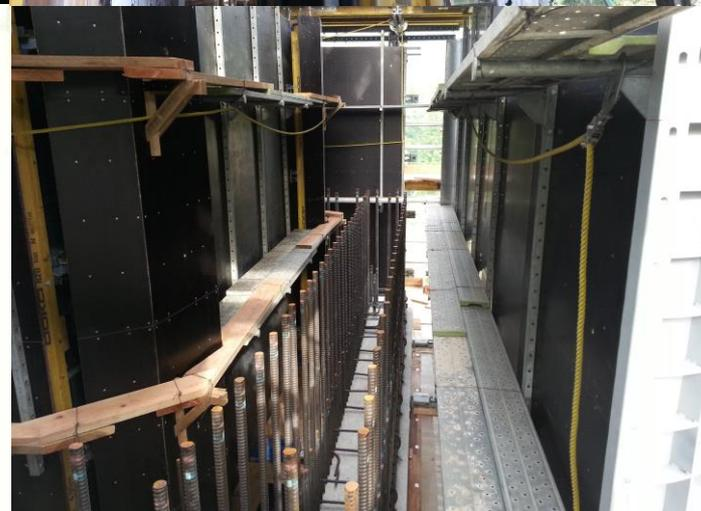
鉄筋建込及び型枠面のケレンとハクリ剤塗布作業
