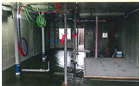
床レベリング工事
