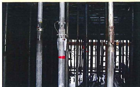
解体前 (打設後約2日目)
