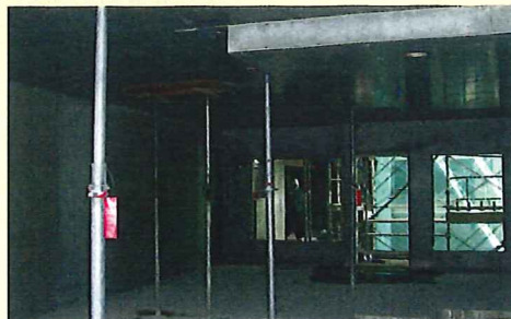
一般支保工解体後 (打設後約4日目以降)
