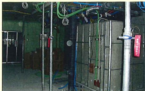
ユニット設置
